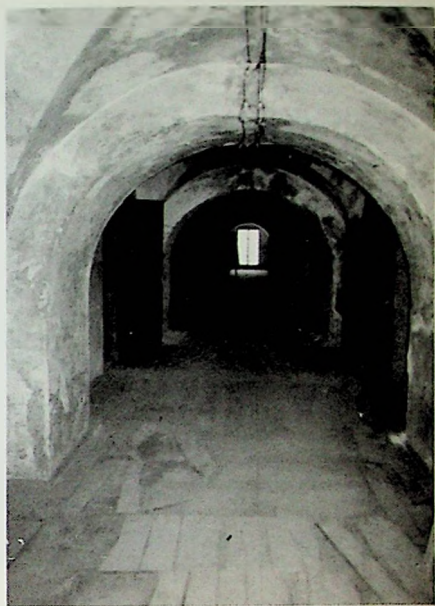
Unutrašnjost kule u Staroj Gradiški
